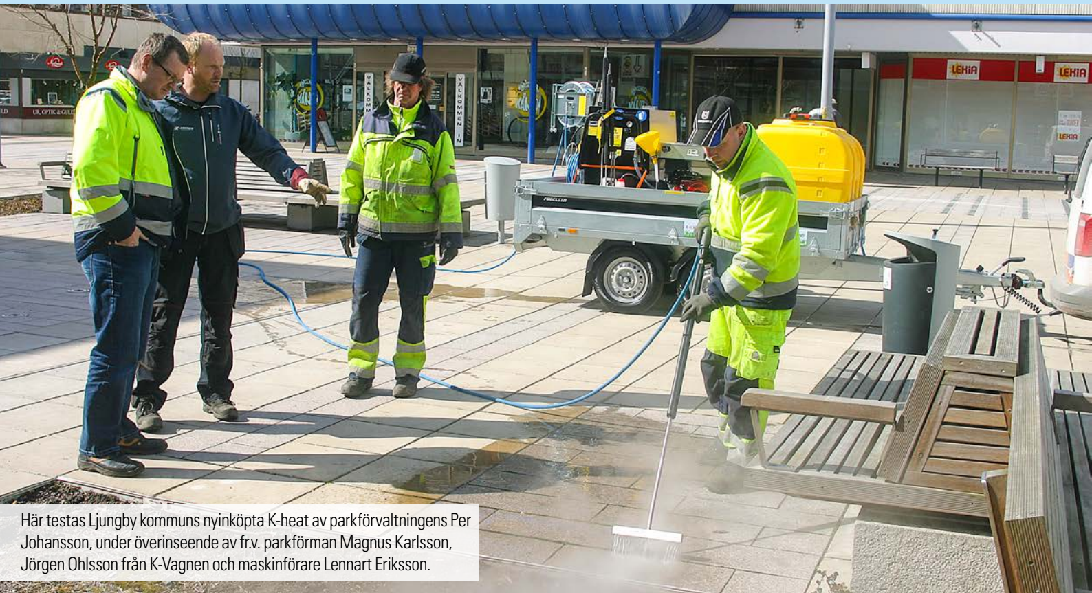
Högtryckstvättning med max 60 grader gör stor skillnad för att få bort avlagringar och smuts.
