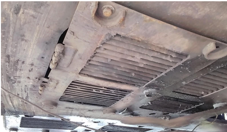
demais tampas do assoalho danificadas e faltando parafusos
