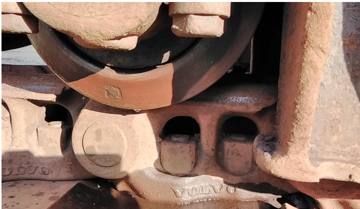
oitavo rolete inferior lado direito danificado
