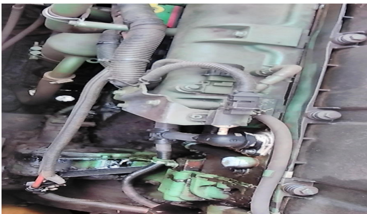
vazamentos no motor diesel
