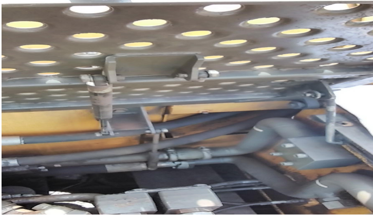
mola a gás da tampa de proteção do comando danificada
