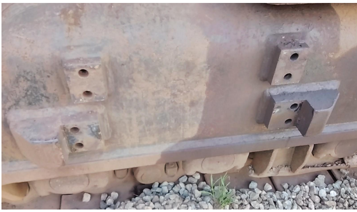
escada superior do carro inferior faltando
