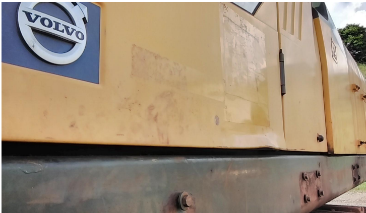
porta da cabine danificada
